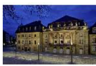
BayO.I, Fassade des Opernhauses und Museums bei Nacht, DI026274, BSV
