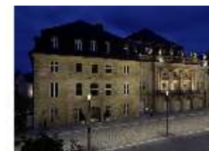
BayO.I, Fassade des Opernhauses und Museums bei Nacht, DI026275, BSV
