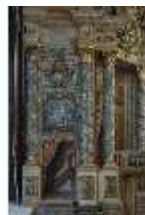
BayO.II, südliche Trompeterloge nach der Restaurierung, DI009946, BSV-
