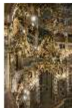
BayO.II, Fürstenloge nach der Restaurierung, DI009976, BSV-
