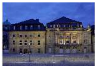
BayO.I, Fassade des Opernhauses und Museums bei Nacht, DI026273, BSV
