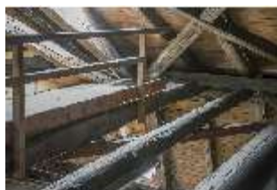
BayO.II, Balken im Dachstuhl, DI029088, BSV-
