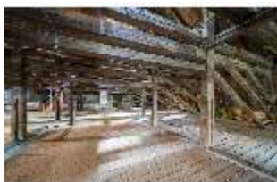
BayO.II, Dachstuhl, DI029087, BSV-
