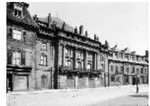
BayO.III,F, hist. Foto, Fassade mit Straßenverlauf, DE002512, BSV
